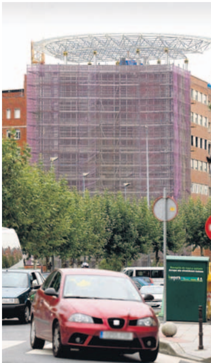
AVANCE. La plataforma es visible desde todo el barrio. / J. ALEMANY
